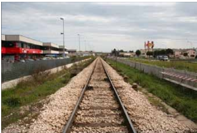
LA LINEA FERROVIARIA VERSO CIVITANOVA MARCHE
