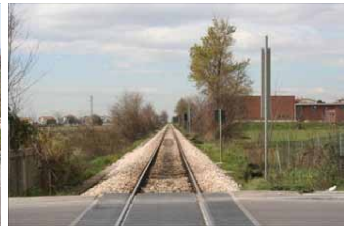
LA LINEA FERROVIARIA VERSO MACERATA
