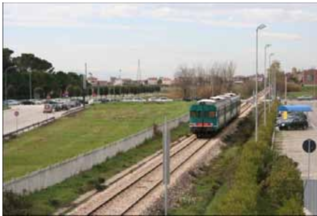
L'AREA DELLA STAZIONE
